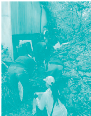
土砂かき作業中
