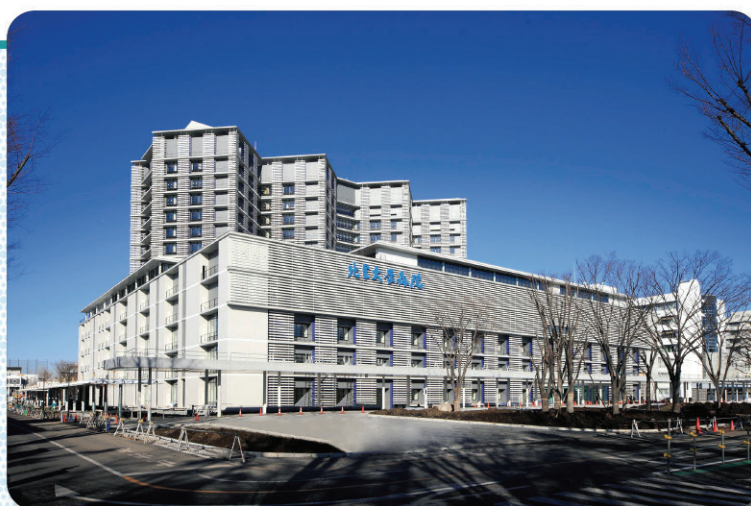
完成近い新病院・・・2013年12月撮影
