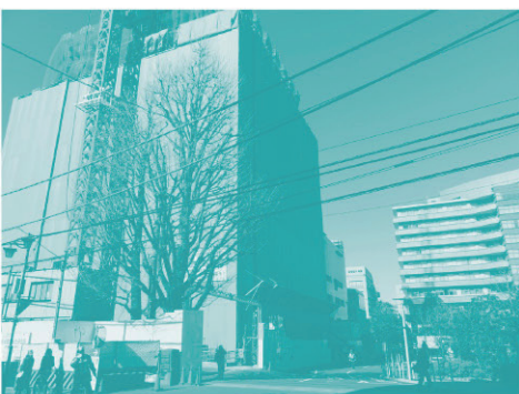
北里本館新設工事
