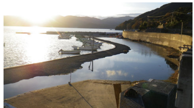
図7 今なお冠水被害が続く崎浜漁港(2012年11月16日撮影) 嵩上げされた部分だけが冠水を免れ、それ以外は大潮時には海水に浸るため近寄ることができない。
