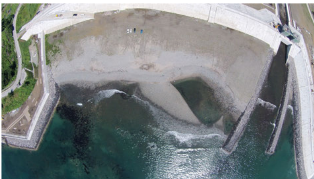
図4 新防潮堤と浦浜海岸(空撮画像)
